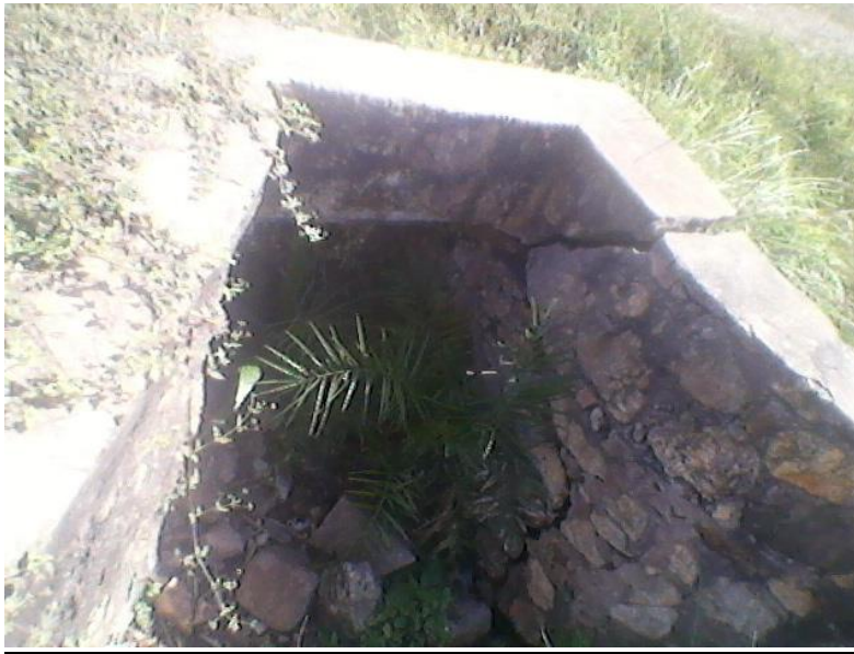
Photo 1 : l'entrée du tunnel dans le village de Bassa
